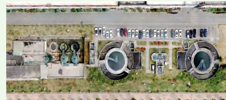
国内工厂污水处理设施
