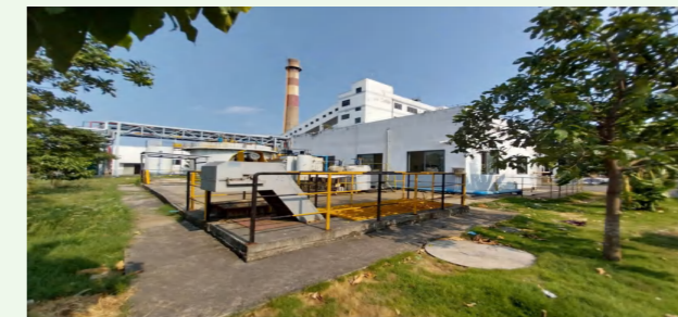
越南工厂污水处理设施
