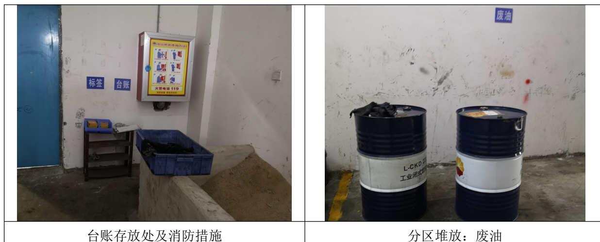
图 5.5-2 危险废物暂存间现状
